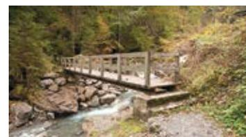
Lorsqu'un chemin de randonnée pédestre traverse un torrent impétueux, il est recommandé d'installer une balustrade (ou garde-corps) des deux côtés du pont ou de la passerelle.
