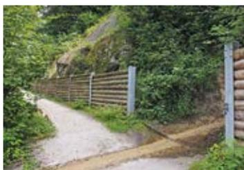
Les gués aménagés permettent de canaliser dans l'Aar les matériaux charriés par les coulées de boue.
